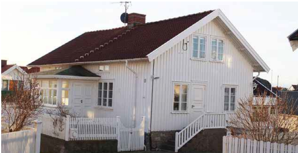
Figur 16. Äldre dubbelhus från 1890. Källa: Kulturmiljöunderlag Koholmen
